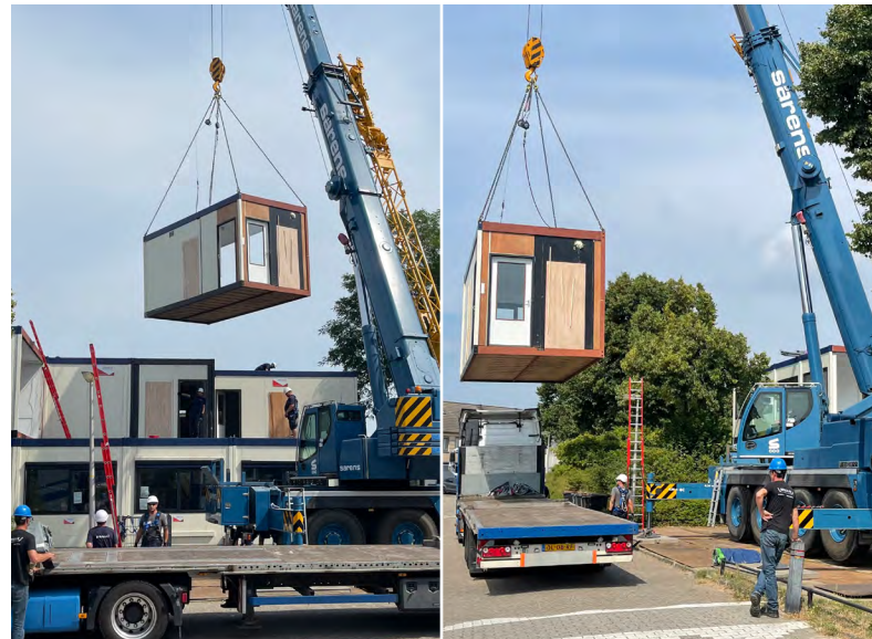
De noodgebouwen worden geplaatst.
