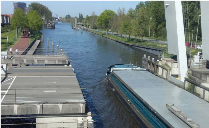
Uitzicht op geopende Jan Blankenbrug.
