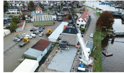
Bouw tijdelijke woningen kanaaldijk.
